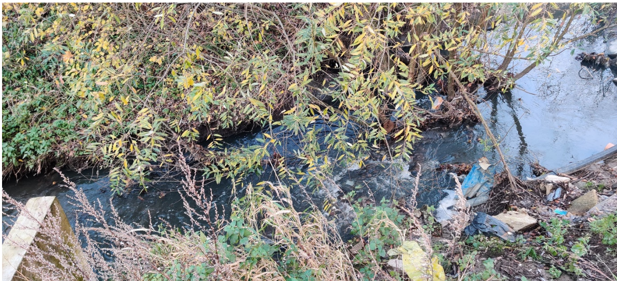
Рис.2 Состояние русла ручья Гагаринского в районе ул. Стрелецкой г. Калининграда
